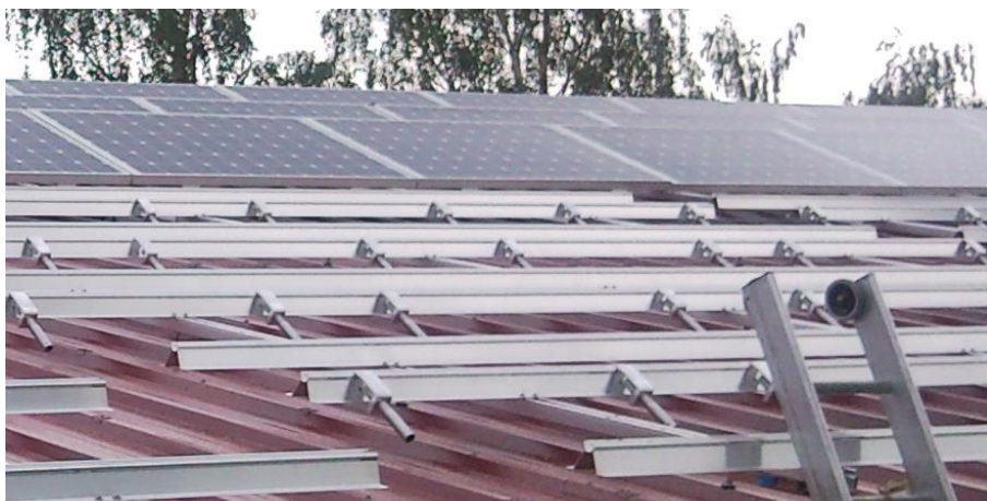
Abbildung 23: Eingelegte Modulstützen-Set (Beispielhaft Süddach mit Stockschraubenmontage)
