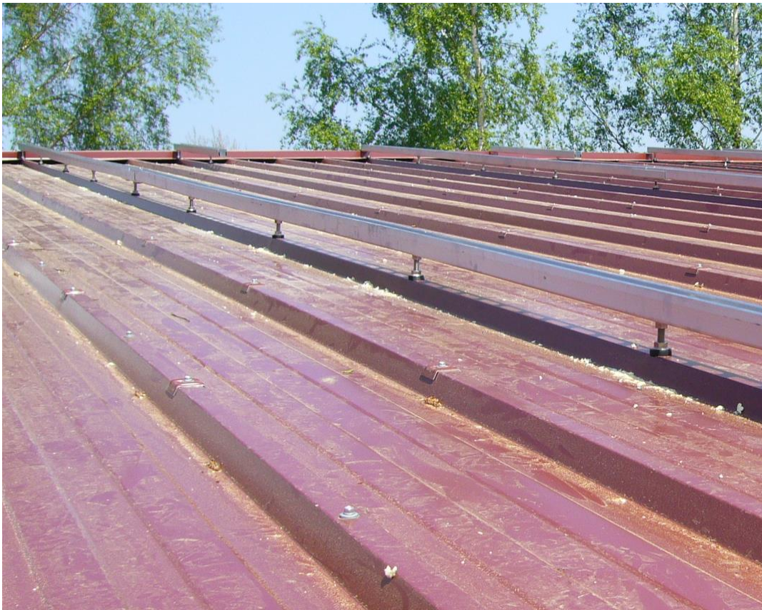
Abbildung 6: C-Schiene als untere Ebene des Kreuzschienenverband
