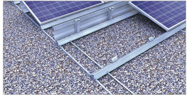
Kiesschüttung: Süd-System I mit Kreuzverbund
