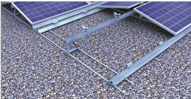
Kiesschüttung: Ost-West-System I mit Kreuzverbund
