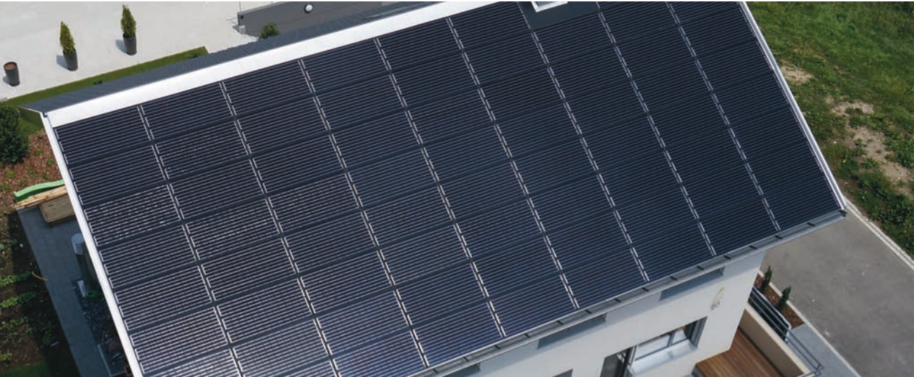
Die Indachlösung – PV-Generator und Dacheindeckung in einem
