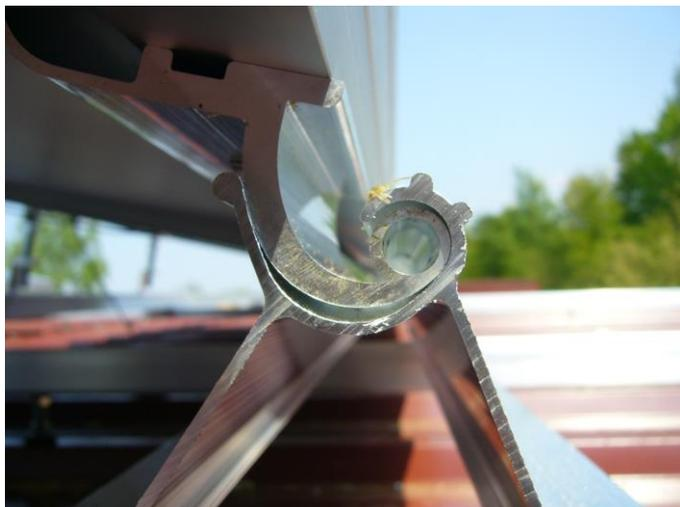
Abbildung 22: Steg (links) und Eindrehschnecke (rechts)
