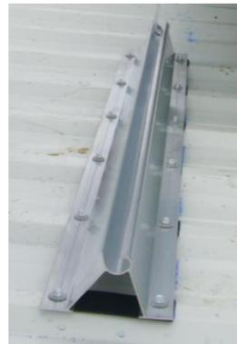
Abbildung 9: Basisprofil mit Abdichtung und beidseitiger Verschraubung. Steg (links) und Eindrehschnecke (rechts).
