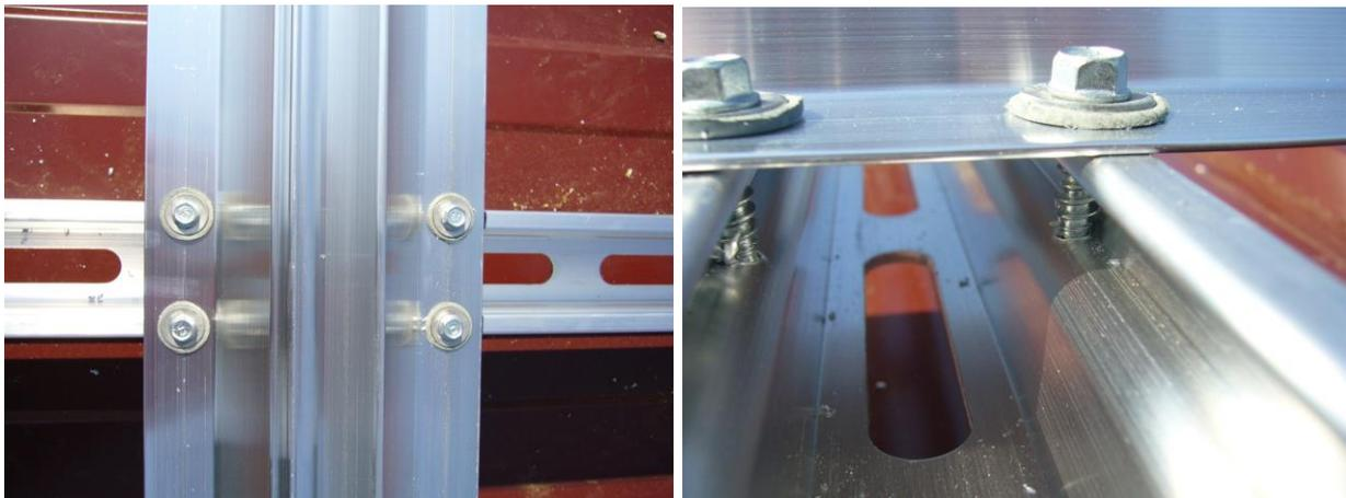
Abbildung 24: Basisprofilbefestigung auf den C-Schienen
