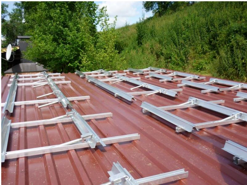
Abbildung 26: Eingelegte Modulstützen-Sets
