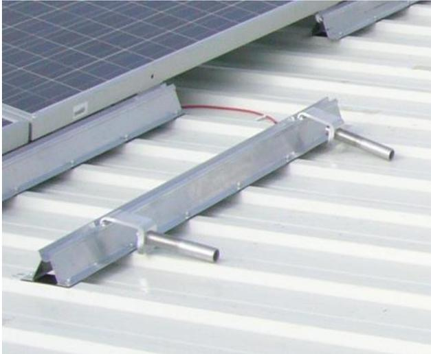
Abbildung 11: Eingelegtes Modulstützen-Set
