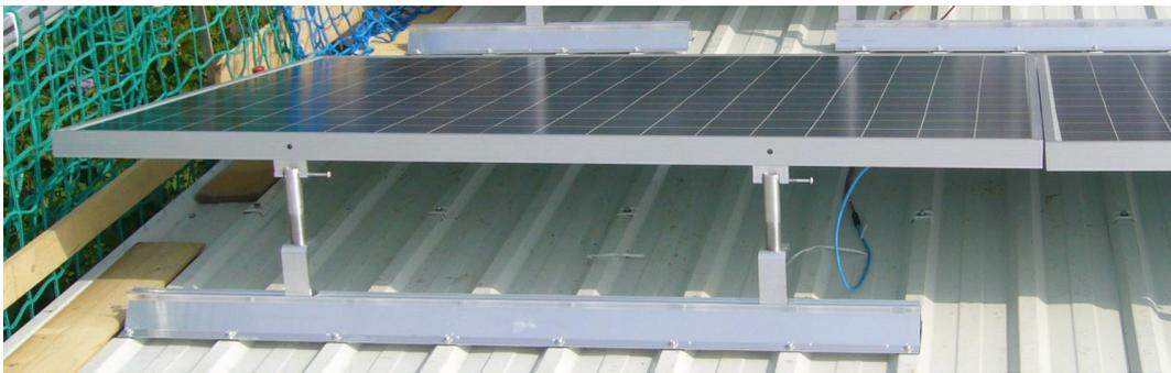
Abbildung 5: Basisprofilverlängerung am Ortgang
