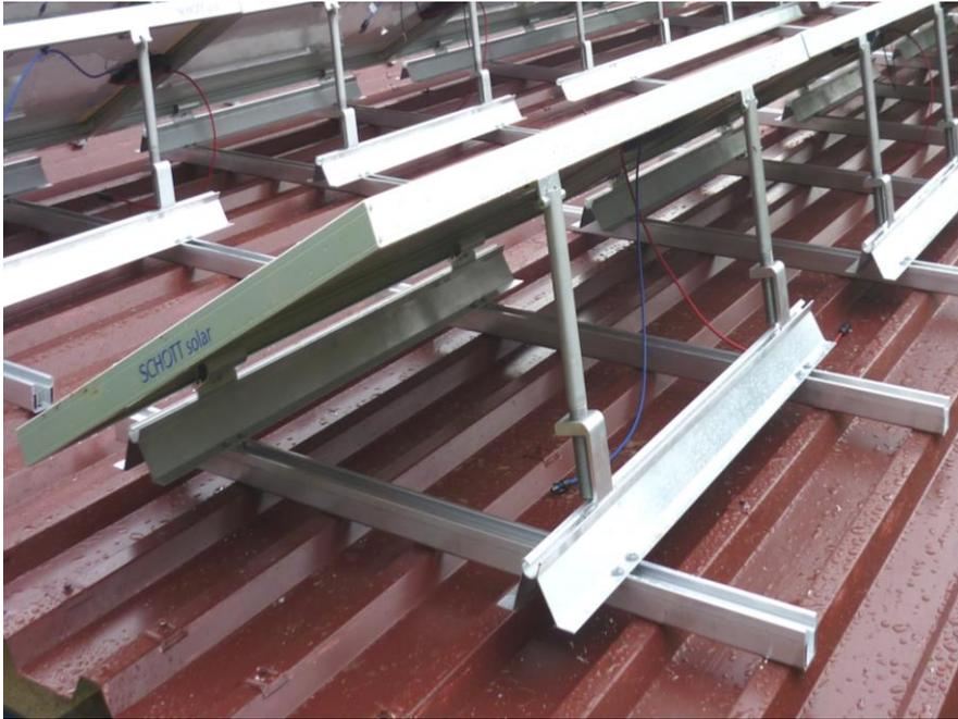
Abbildung 27: Höhenverstellbare Modulstützen
