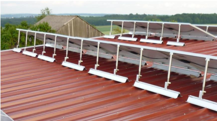
Abbildung 12: Höhenverstellbare Modulstützen
