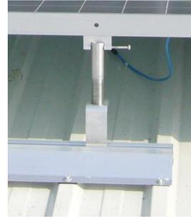
Abbildung 4: Detail zur Befestigung der Basisprofile am Trapezblech - Standardbefestigung
