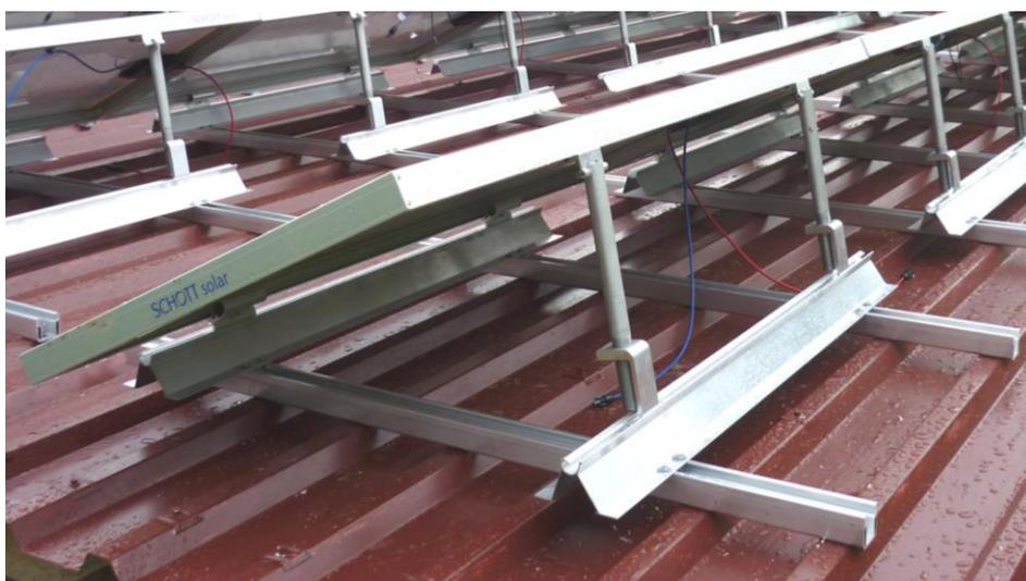
Abbildung 17: C-Schiene als untere Ebene des Kreuzschienenverband
