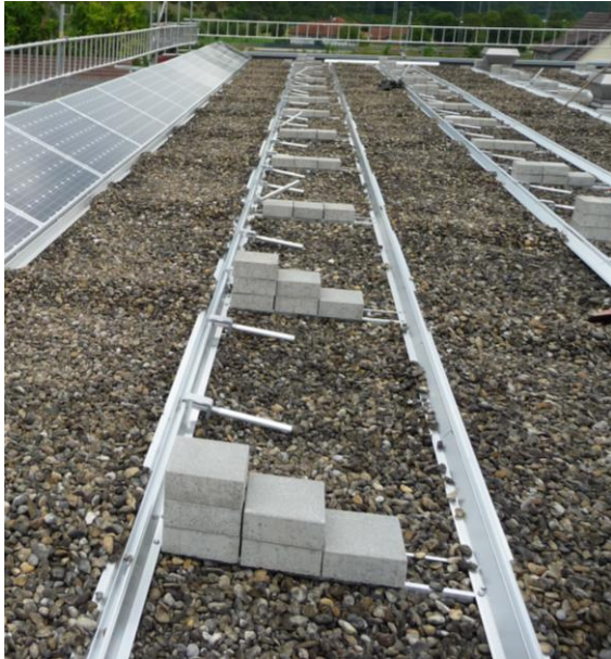
Abbildung 30: Eingelegte Modulstützen-Set
