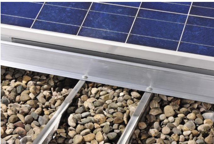
Abbildung 28: Kiesballastierung in der Grundschiene 230 - 90
