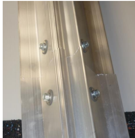
Abbildung 12: Verbinder Grundschiene und Verbinder Basisprofil in eingebautem Zustand
