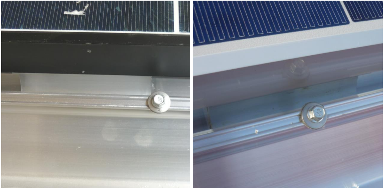
Abbildung 65: Modulsicherung am „Modulbefestiger-Set vorne“ neben oder durch den Modulbefestiger
