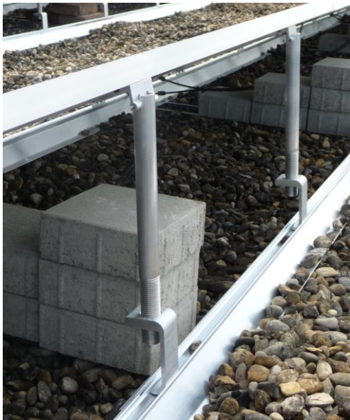
Abbildung 31: Höhenverstellbare Modulstützen
