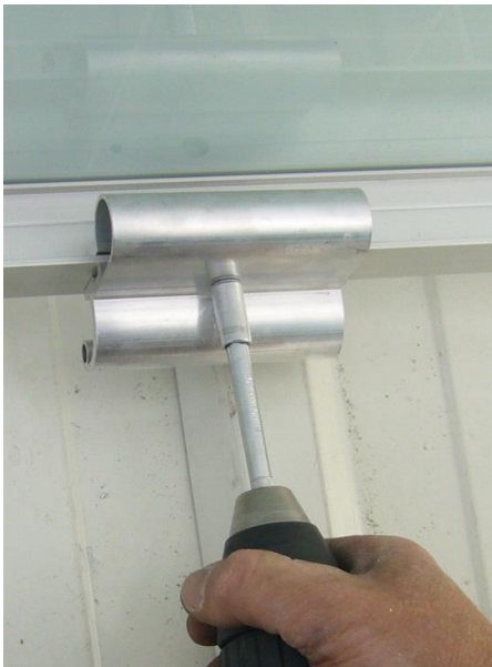
Abbildung 45: Montage „Modulbefestiger-Set“ vorne
