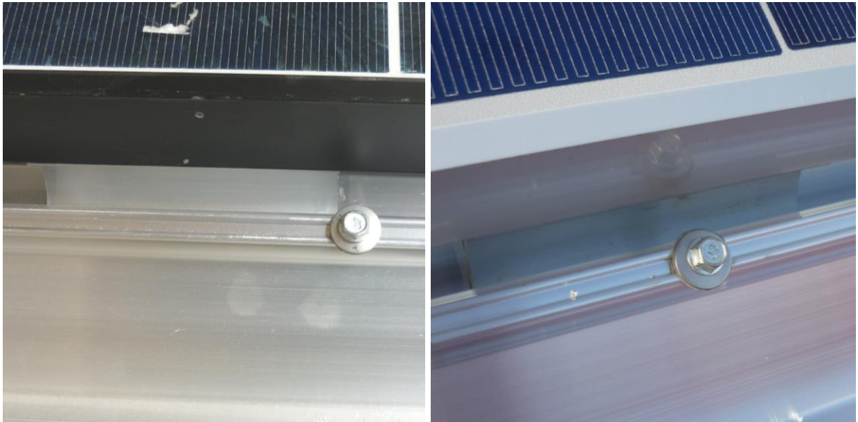
Abbildung 48: Modulsicherung am „Modulbefestiger-Set vorne“ neben oder durch den Modulbefestiger
