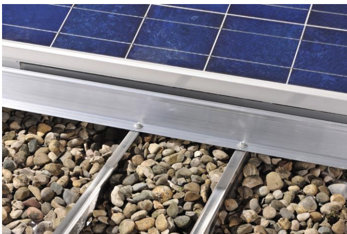
Abbildung 44: Kiesballastierung in der Grundschiene 230 - 90
