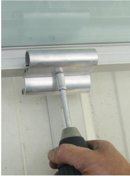
Abbildung 63: Montage „Modulbefestiger-Set“ vorne
