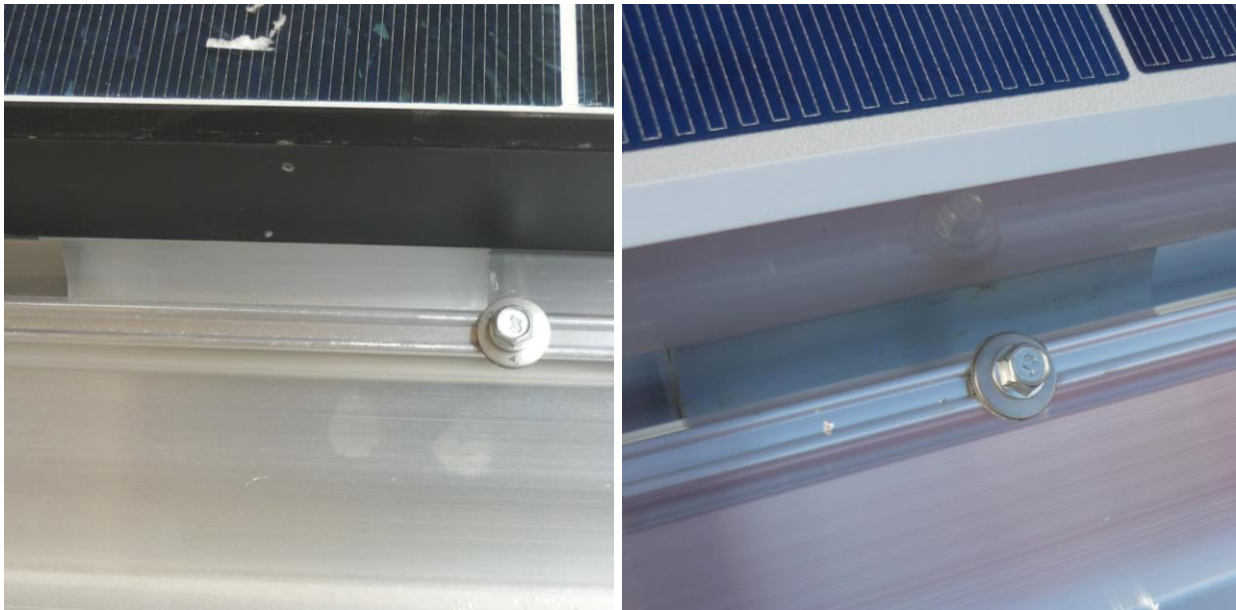
Abbildung 32: Modulsicherung am „Modulbefestiger-Set vorne“ neben oder durch den Modulbefestiger
